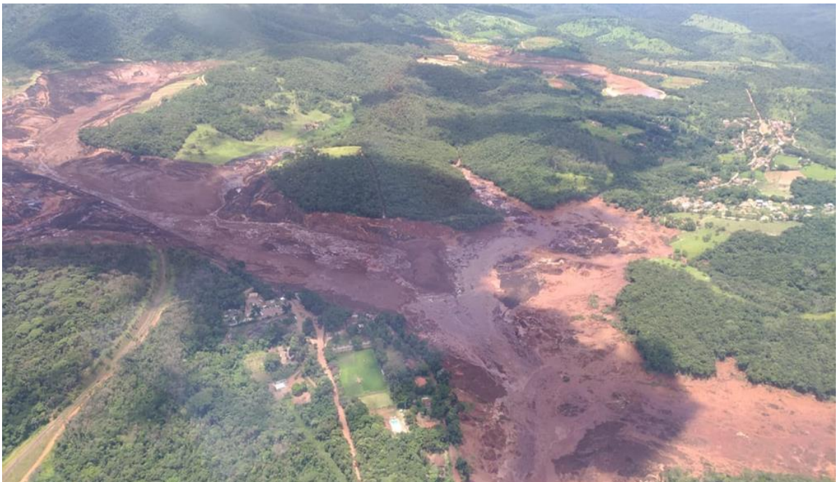
Figura 4 - Mina Córrego do Feijão: depois do desastre-crime
