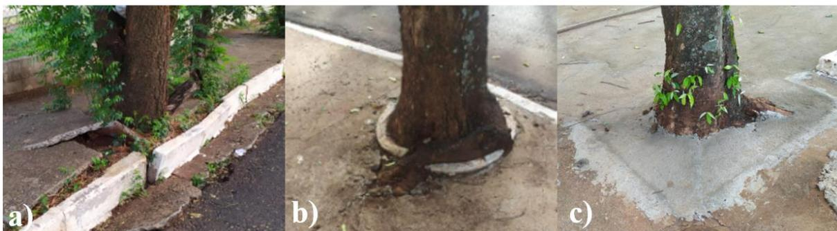
**Figura 8** – Estrangulamento da base caulinar da vegetação nas praças de Frutal-MG: a) Limite de borda atingido pelo pavimento; b) Crescimento em tubos; c) Adição de concreto na base caulinar
