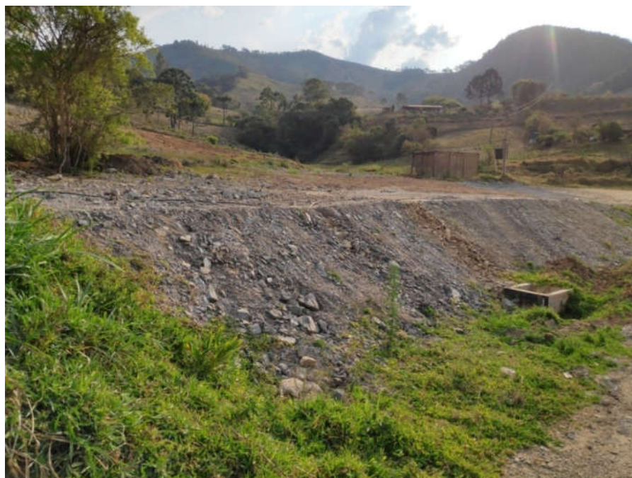
Figura 45 – Construção de aterro para conformar erosão Fonte: Elaborada pelo autor (2022).
