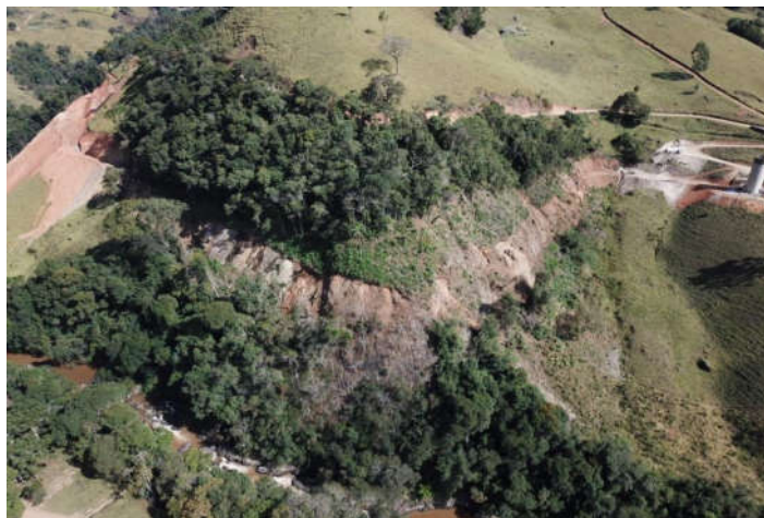
Figura 29 - Vista aérea do conduto de baixa pressão
