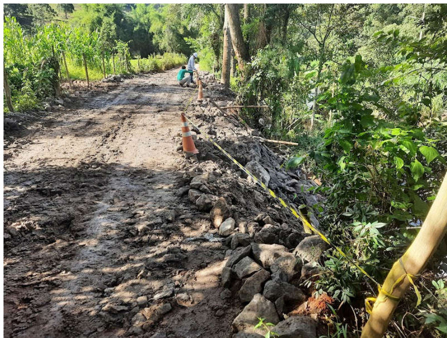
Figura 44 – Restauração de estrada na zona rural do município de Alagoa/MG Fonte: Elaborada pelo autor (2022).
