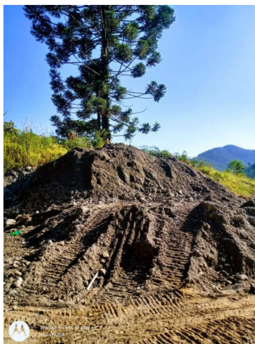
Figura 43 – Resíduos de rocha originados da limpeza do piso do túnel
