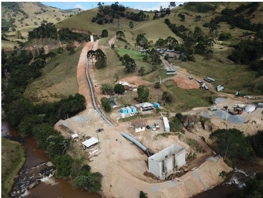
Figura 4 - Visualização da chaminé de equilíbrio, do conduto de alta pressão e da casa de força
