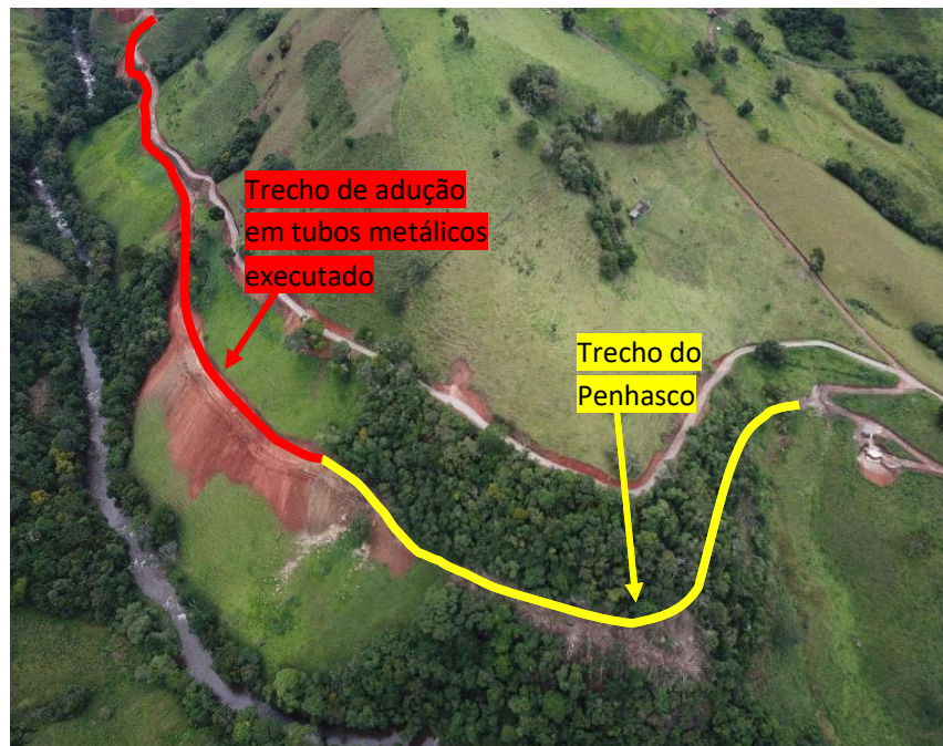
Figura 27 - Supressão de vegetação e mobilização de terra para passagem do conduto no trecho do penhasco e suas proximidades Fonte: CGH ALAGOA 2 ENERGIA LTDA (2021).
