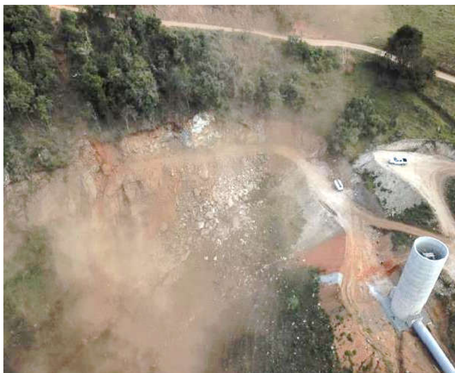
Figura 32 -Vista aérea da escavação em rocha no trecho do penhasco, nota-se a grande quantidade de matéria em suspensão.
