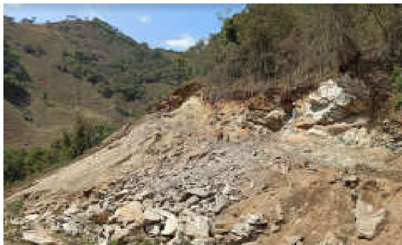
Figura 31 -Blocos e sedimentos que rolaram após detonações e reentrâncias criadas no maciço
