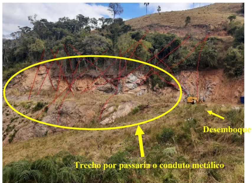
Figura 21 - Direções preferenciais do fraturamento do maciço no desemboque do túnel Fonte: Elaborado pelo autor (2022).
