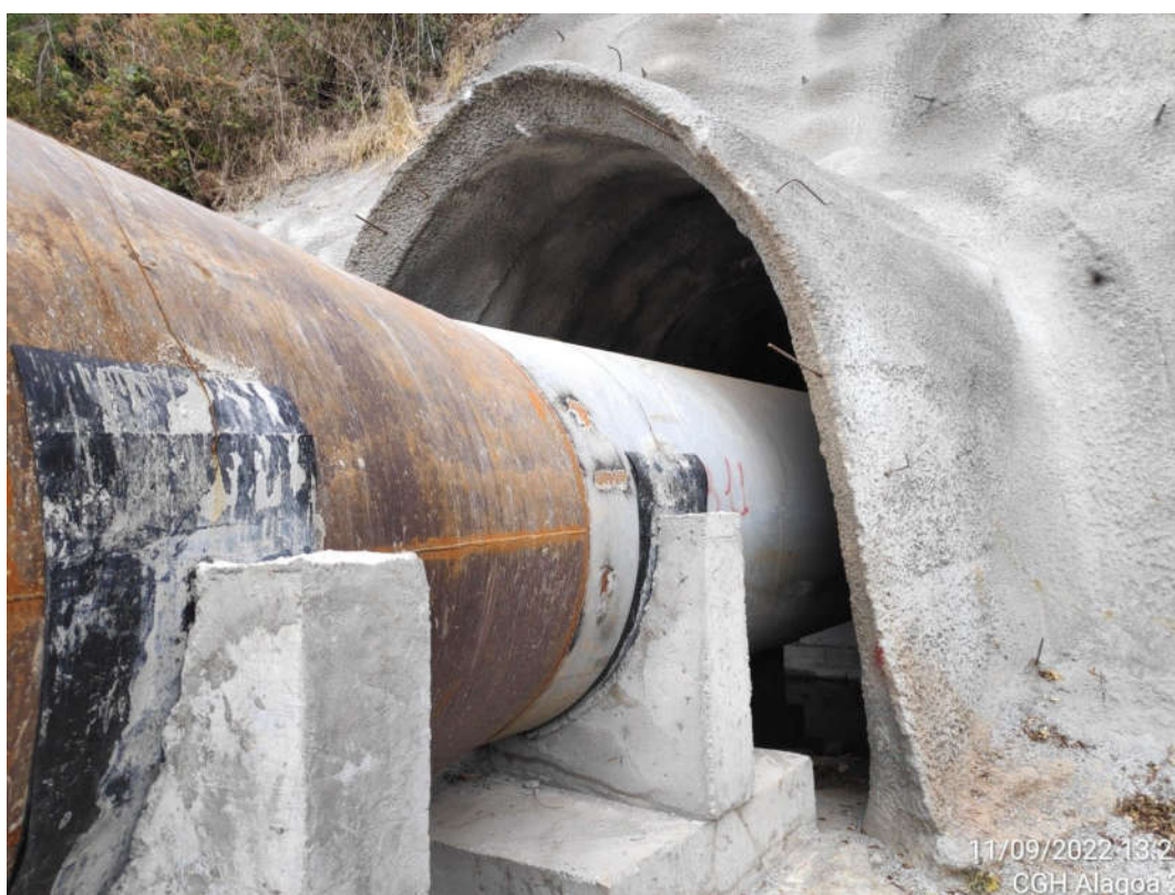
Figura 47 – Conduto externo acessando o túnel através do emboque de montante Fonte: Elaborado pelo autor (2022).
