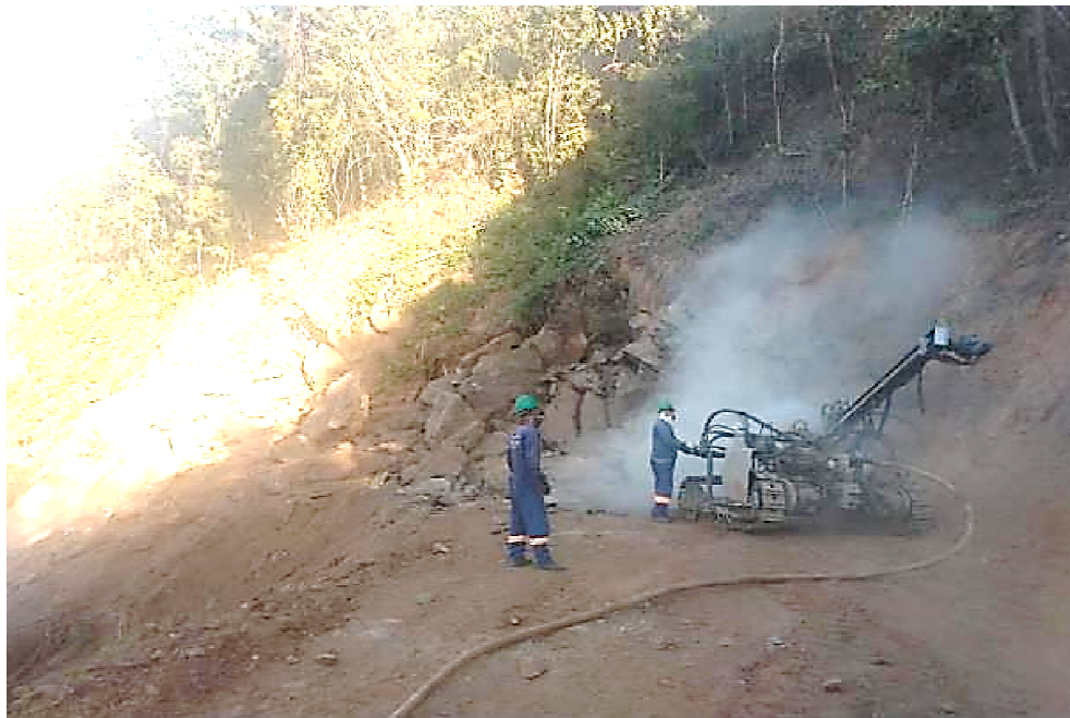
Figura 33 - Perfurações sendo realizadas horizontalmente
