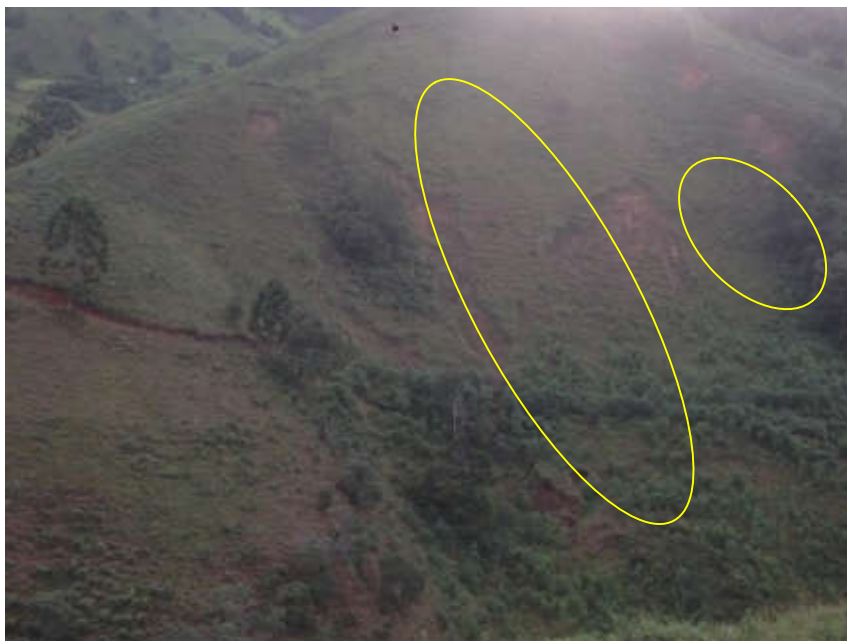
Figura 18 - Áreas de instabilidade e fluxos gravitacionais Fonte: WELT ENERGIA(2016).
