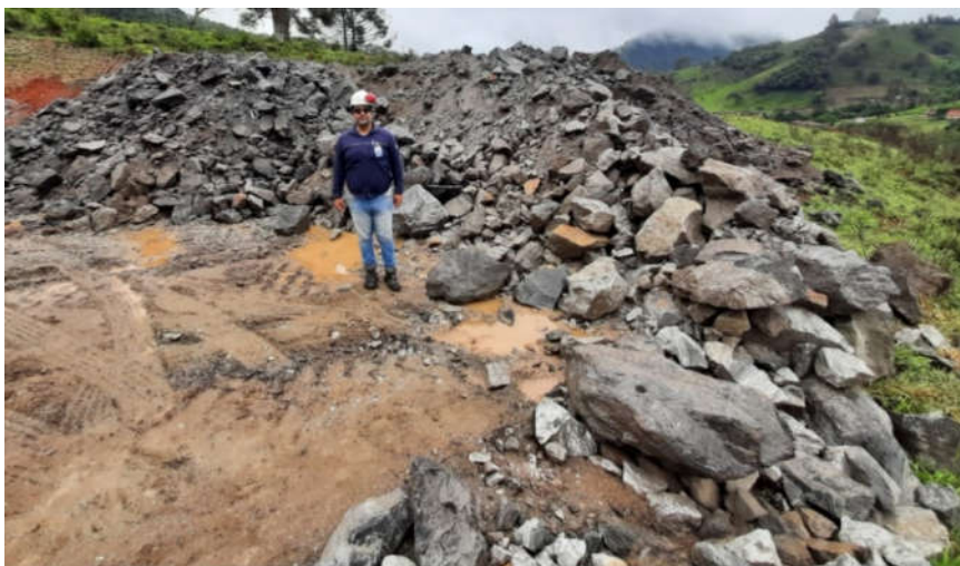
Figura 42 - Área de empréstimo para transbordo dos resíduos rochosos retirados do túnel
