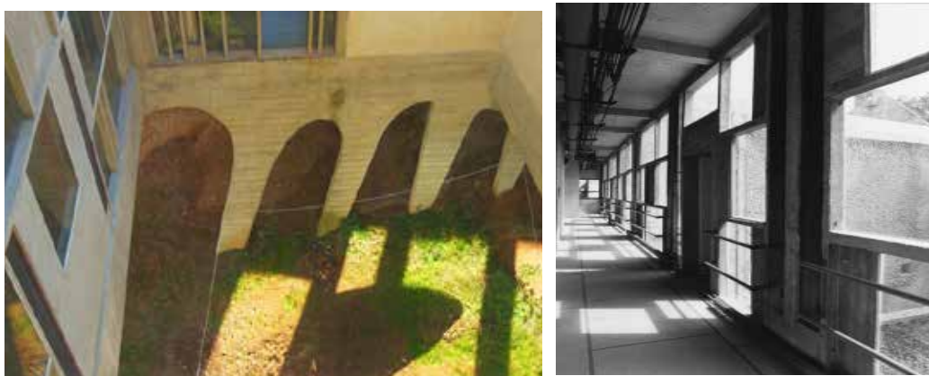
Figuras 8 e 9 – Convento de Sainte-Marie-de-la-Tourette, Le Corbusier
